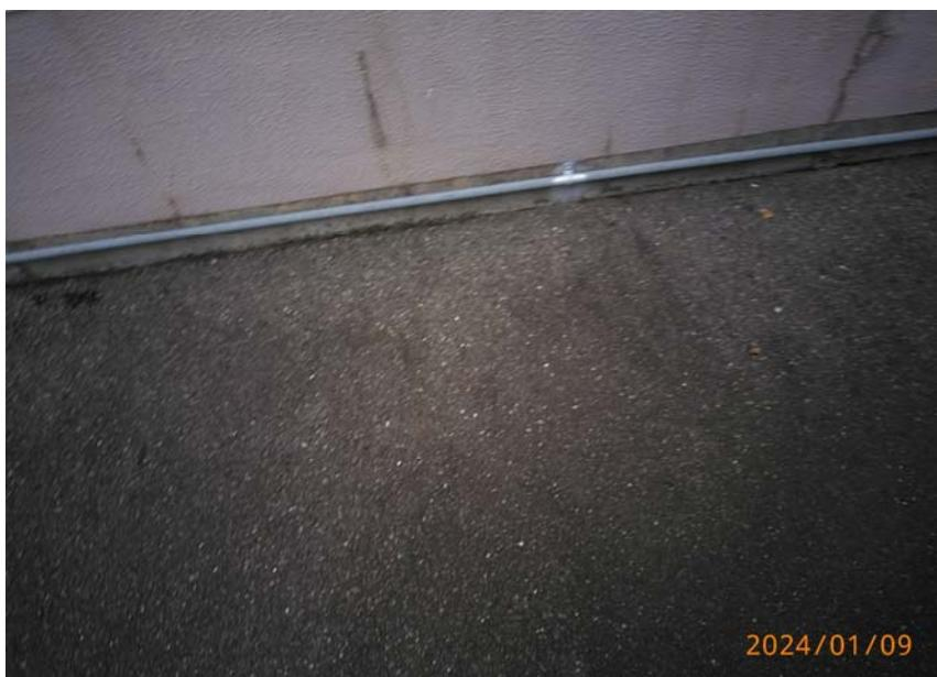
一部配管と配管支持サビ補修
