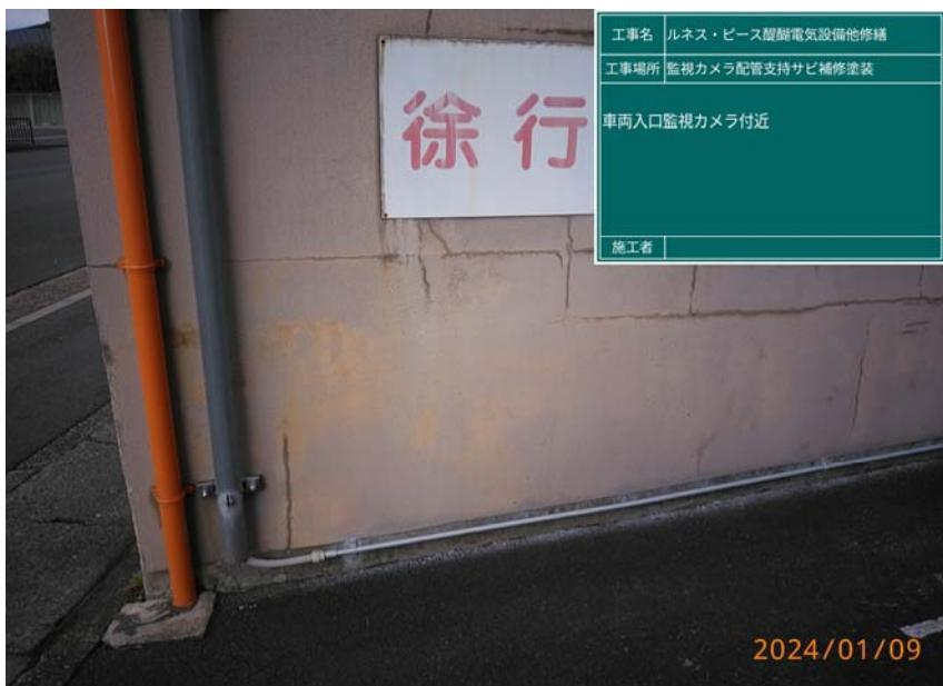
一部配管と配管支持サビ補修
