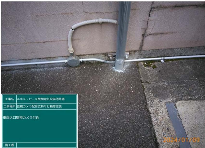
一部配管と配管支持サビ補修
