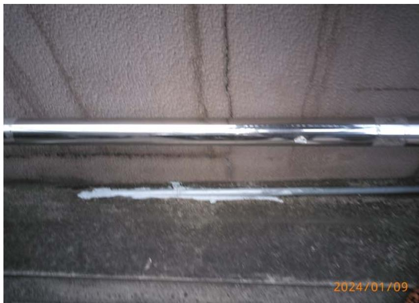
一部配管と配管支持サビ補修
