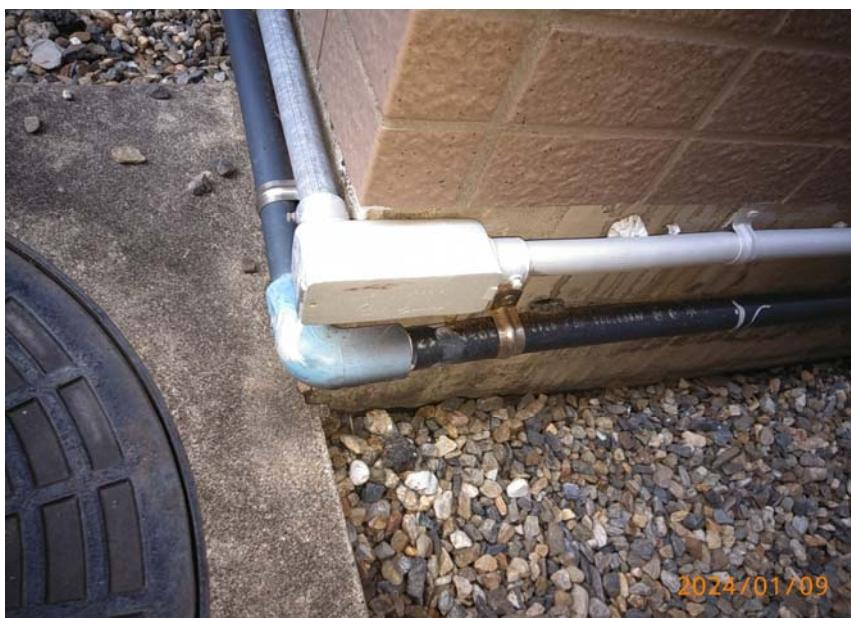
一部配管と配管支持サビ補修
