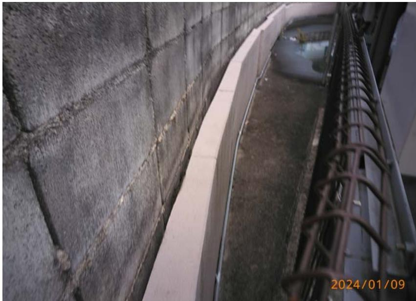
一部配管と配管支持サビ補修
