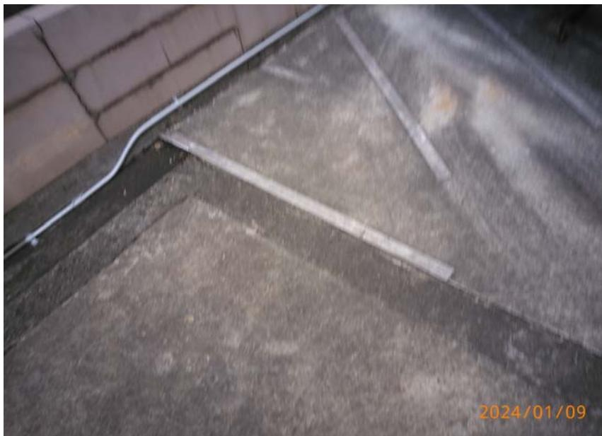
一部配管と配管支持サビ補修
