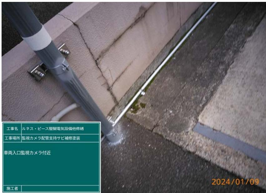
一部配管と配管支持サビ補修
