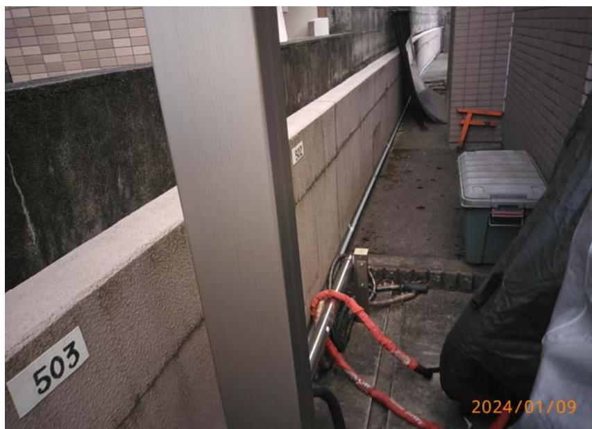
一部配管と配管支持サビ補修
