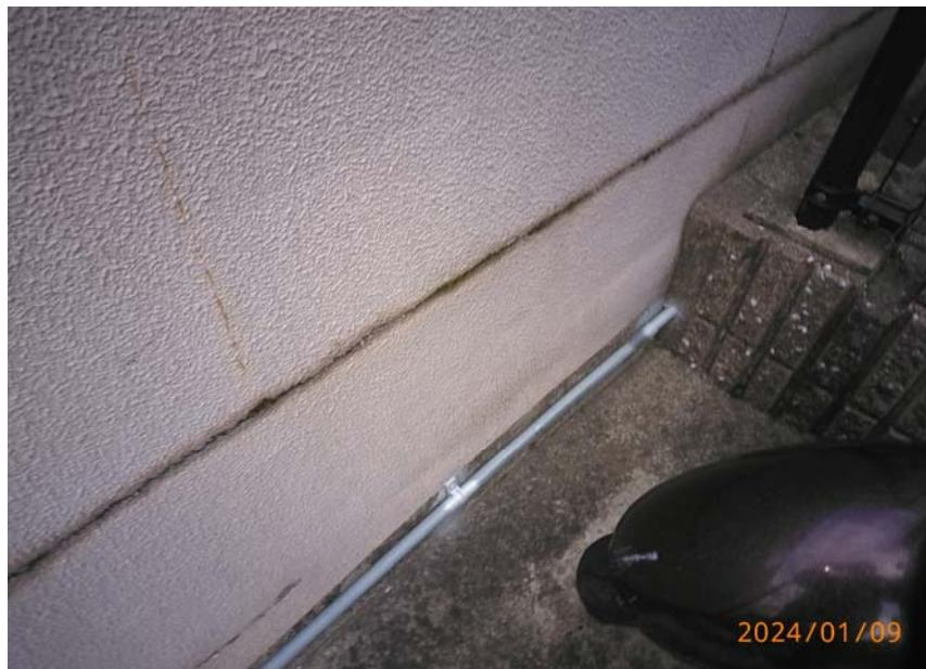
一部配管と配管支持サビ補修
