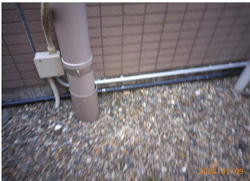
一部配管と配管支持サビ補修
